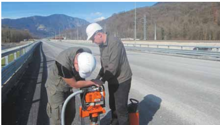
Работники Северо-Кавказского филиала ФГУП «РОСДОРНИИ» производят строительный контроль на участке дороги Адлер — горноклиматический курорт «Альпика - Сервис»
