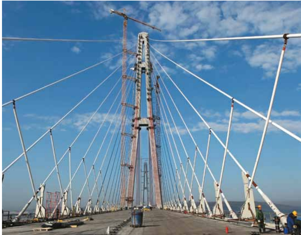
Приемочное обследование и испытание моста на остров Русский
