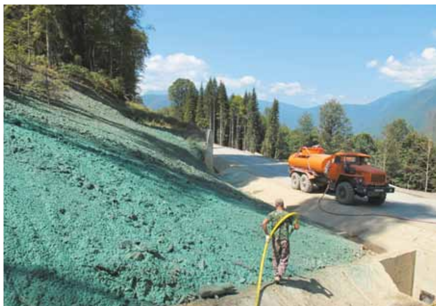
Откосы горных дорог укрепляются напылением комплекса «Флекстерра»
