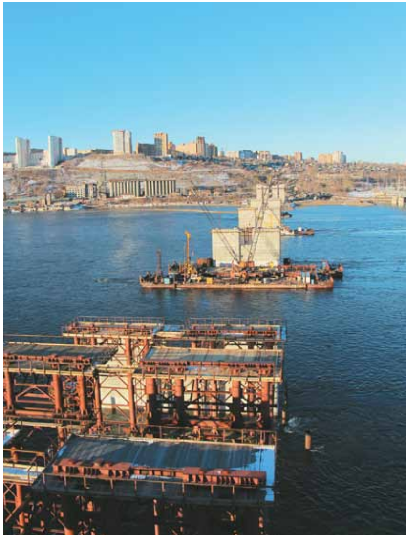
Строительство 4-го моста через Енисей, декабрь 2013 г.
