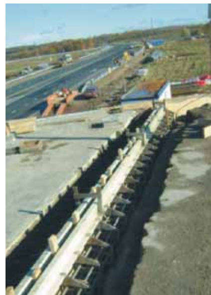
Установка конструкции деформационного шва СК-80, Переславль-Залесский
