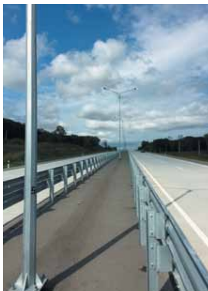
Ограждение на Президентском мосту (г.Ульяновск)
