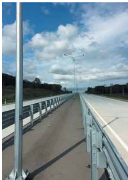
Ограждение на Президентском мосту (г.Ульяновск)
