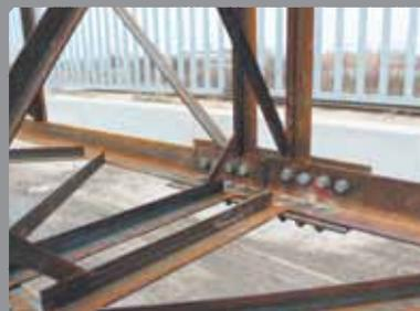
**Серийный выпуск** ригелей жестких поперечин осуществляется по ТУ 5264-845-01393674-07 «Ригели жестких поперечин для контактной сети железных дорог балочного типа. Технические условия» и в соответствии с рабочими чертежами 5254 «Унифицированные конструкции жестких поперечин балочного типа» (выпуск 1 «Ригели жестких поперечин и материалы для проектирования» и выпуск 2 «Металлоконструкция блоков ригелей»).
